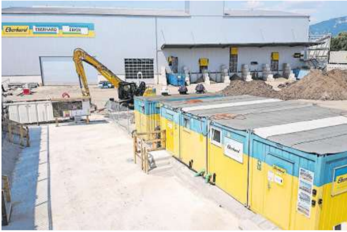
Blick vom Besucherpavillon auf den Installationsplatz.
